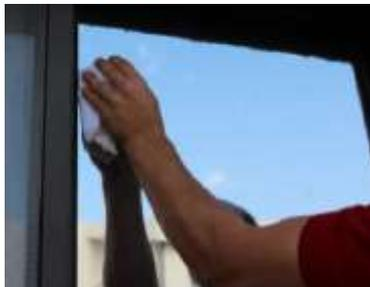
**Paso 12:** Seque los bordes del film y la ventana utilizando una tarjeta envuelta en papel absorbente.
