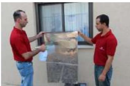
**Paso 6:** Retire el soporte del film y rocíe la capa de adhesivo expuesta con abundante solución humectante.
