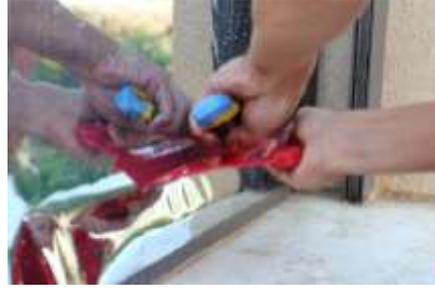
**Paso 9:** Corte los bordes del film junto al marco de la ventana, utilizando la cuchilla Stanley y la herramienta para bordes.
