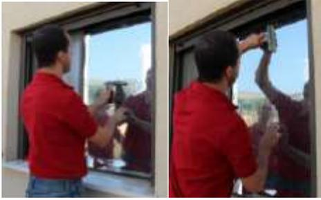
**Paso 8:** Pase una espátula dura de 6" desde el centro hacia los extremos con movimientos firmes hacia abajo y hacia el exterior, sacando el agua y el aire que hubiera quedado atrapado entre el film y el cristal.
