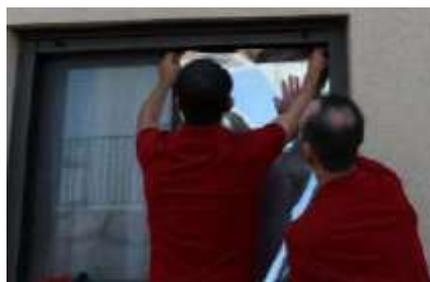
**Paso 7:** Coloque el film en la ventana con la parte del adhesivo humedecida sobre el cristal.
