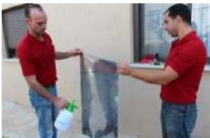
**Paso 2:** Rocíe el film por ambas caras para evitar la energía estática (menos suciedad en la instalación) y aplane el film.
