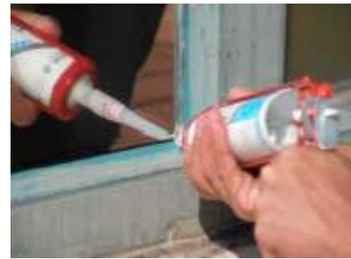
**Paso 13:** Deje secar el film durante 24 horas y en las siguientes 72 horas complete el sellado de los bordes
